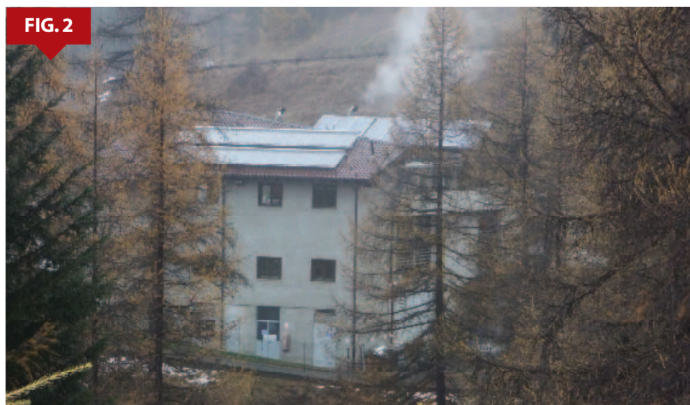
Fig. 2. Le due sezioni dell'impianto solare (foto: Degmar)
